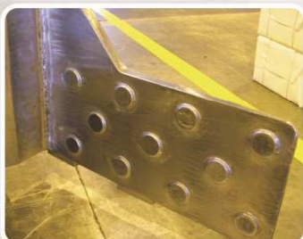
Sistema de aderência interna através de bolachas inox.
