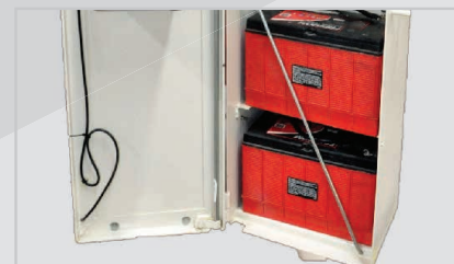
Alimentação elétrica através de baterias internas.
