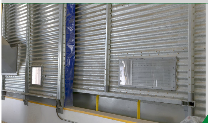
Revestimento em chapa ondulada, maior resistência e melhor vedação
