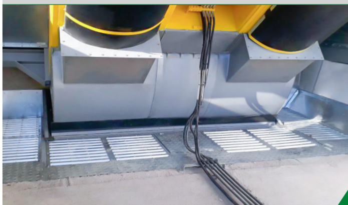
Sistema de concha e piso metálico substituem fechamento em lona
