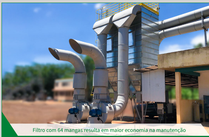
Revestido com chapa ondulada, melhor vedação e resistência
