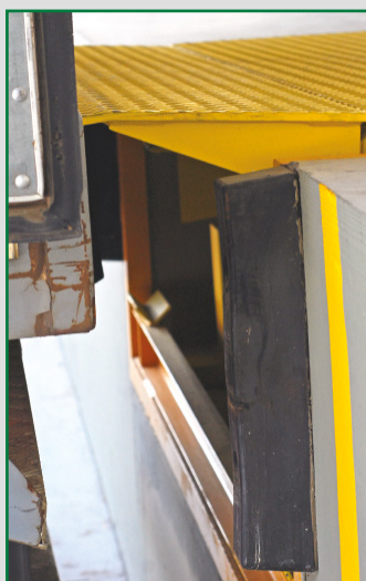
Perfil tubular que confere mais resistência na parte inferior da Niveladora.
